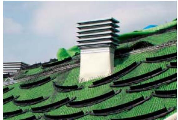
Größere Netzausschnitte erfordern eine Überbrückung mittels Klemmschienen über und unter den Ausschnitten.
