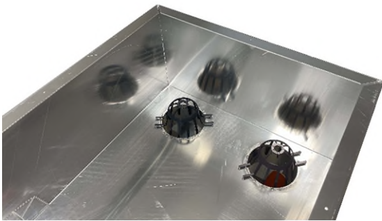
Abbildung 7: Laubfangkörbe einsetzen
