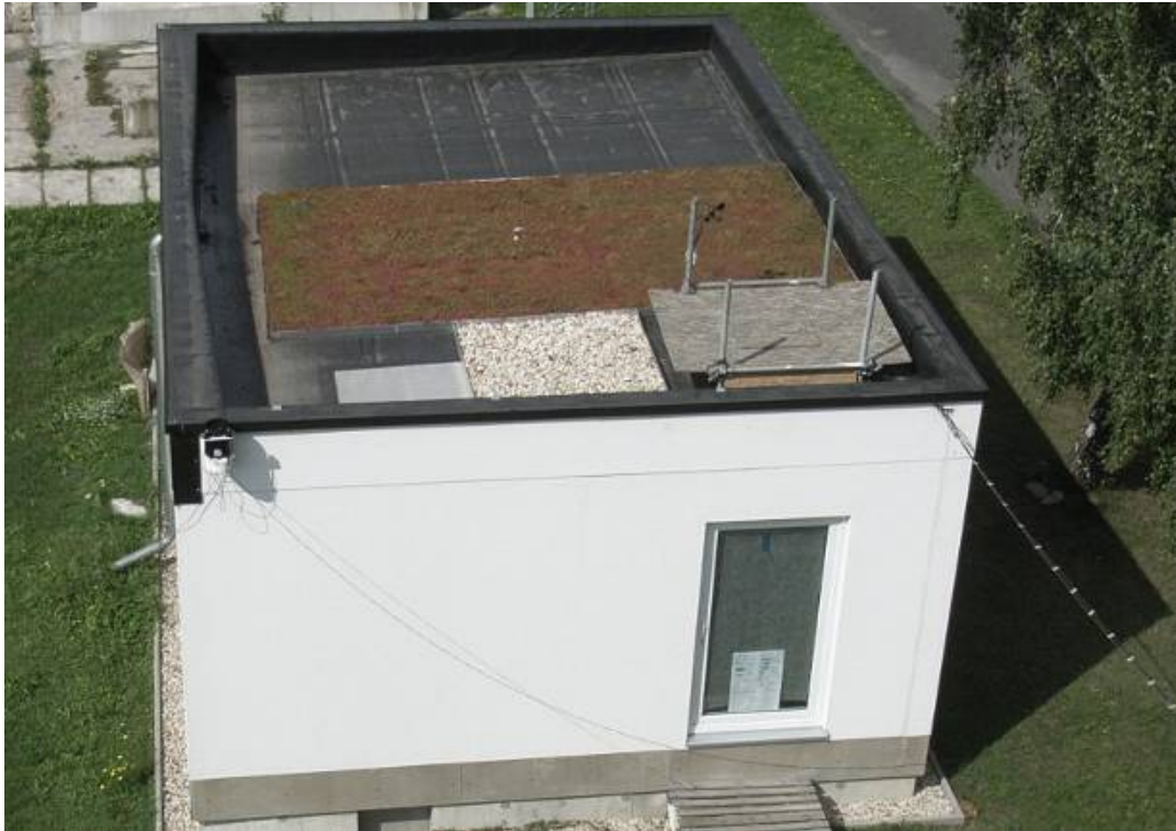
Bild 12: Versuchsstand auf dem Freilandversuchsgelände der MFPA Leipzig mit den verschiedenen, untersuchten Versuchsfeldern [2].
