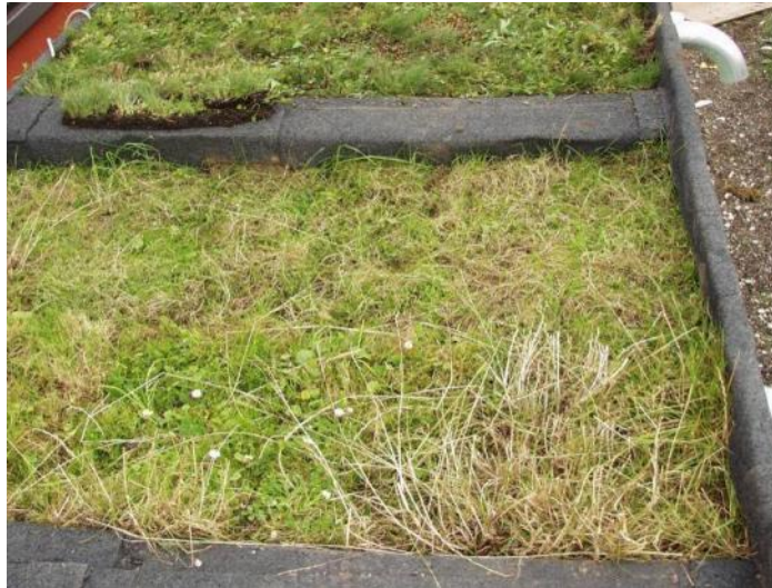
Bild 27: Fotographische Ansicht eines von fünf Gründach-Versuchsfelder auf dem Dach des Zentrums für Umweltbewusstes Bauen in Kassel [1].
