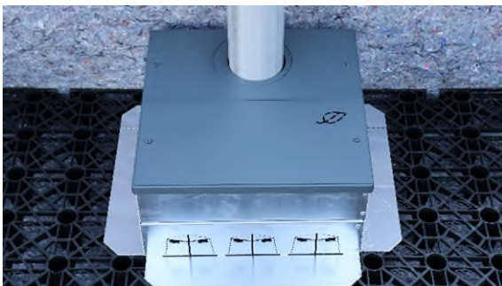
Abbildung 15: Zweites Deckelement montieren
