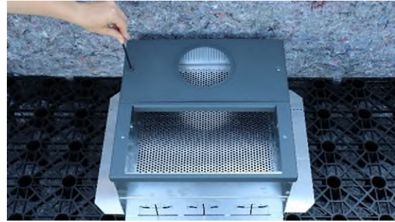
Abbildung 12: Deckelement mit Rohraussparung auflegen und befestigen
