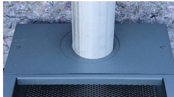
Abbildung 14: Montierter Deckel mit Fallrohr
