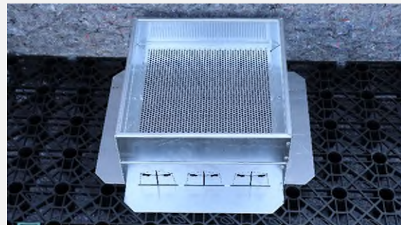
Abbildung 10: Schacht auf WRB auflegen
